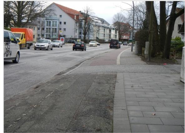
Abb. 62 Schadhafter asphaltierter Radweg zwischen Brooksheide und Luckmoor
